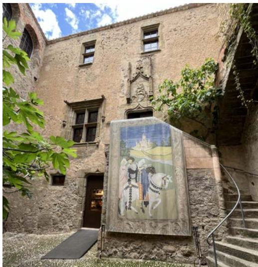
La façade principale du patio du château de Púbol.
